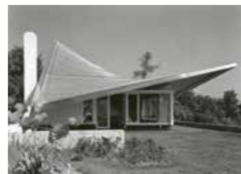
Felix Schwarz, Rolf Gutmann, Haus Vischer, Hégenheim, Haut-Rhin (F), 1960/61. – Die extravagante Dachkonstruktion stammt von Ingenieur Heinz Hossdorf. Foto: Alexander von Steiger
