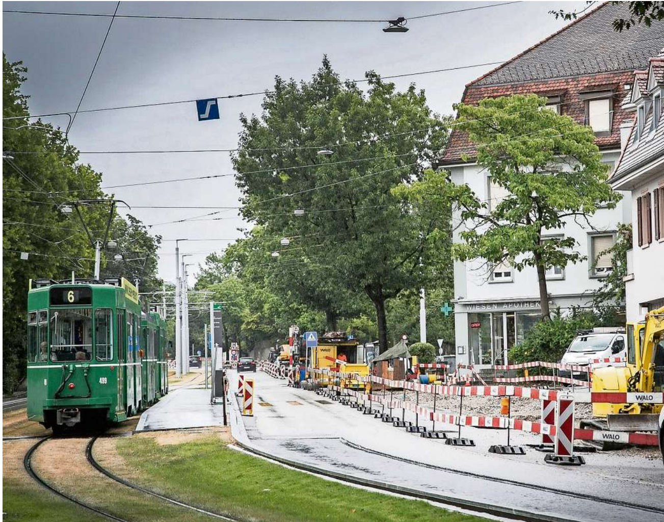
Fünf Jahre Baustelle. Entlang der Äusseren Baselstrasse gehören Umleitungen und Behinderungen zum Alltag. Foto Nicole Pont
